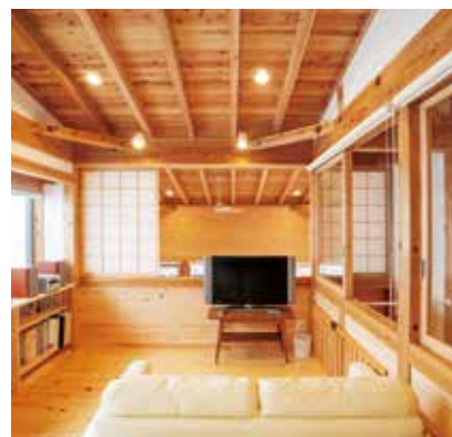
野地板や垂木などをあえて見せるデザインで、木の魅力を活かします。
